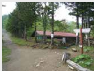
解体前の旧奥多摩小屋
